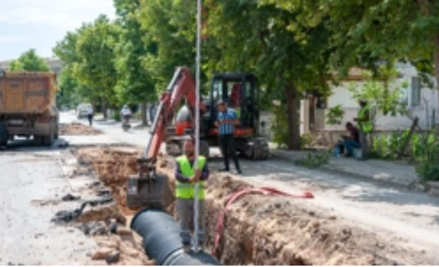
İZSU'dan Urla'da altyapı çalışmaları
